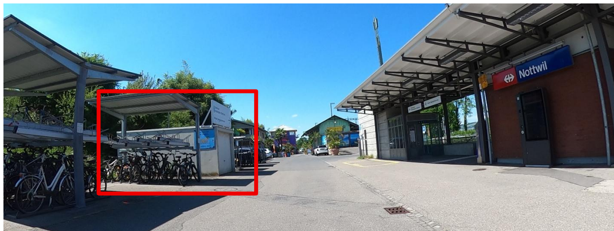
Abbildung 9: Foto Begehung mit bestehender Garage
